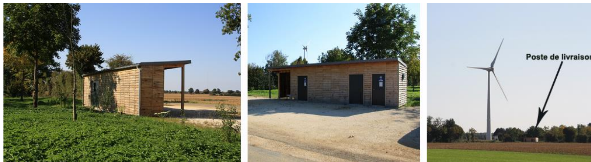
Poste de livraison du projet en place sur lequel seront raccordées les 3 futures machines
